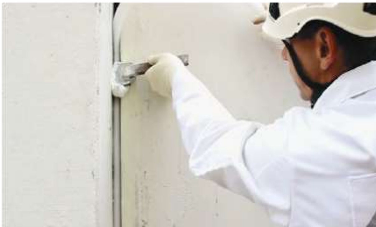
Рисунок 7 - Нанесение в стыки мастики
